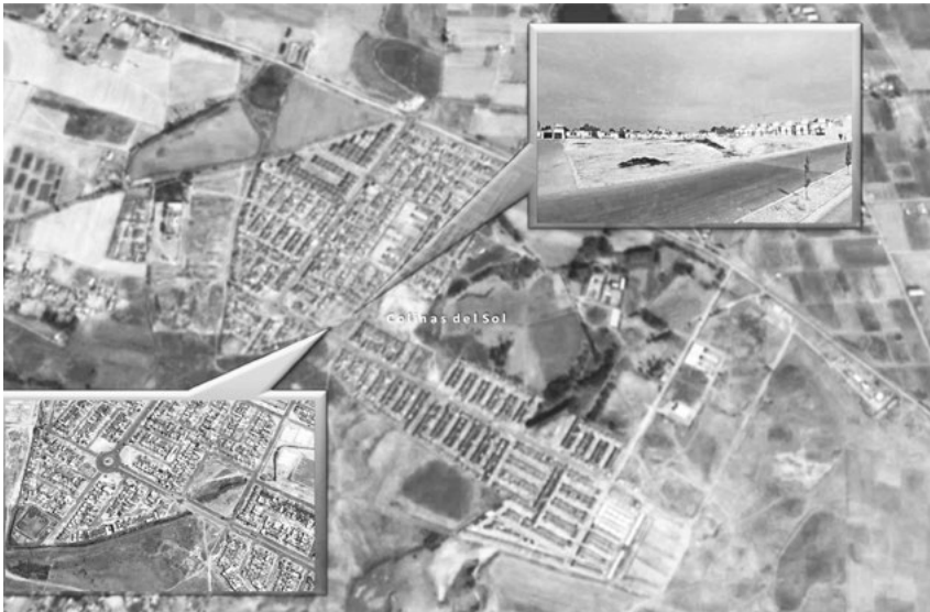
Figura 6. Detalle del canal (derecho de vía) que atraviesa el predio destinado a jardín vecinal y módulo deportivo, en el conjunto Colinas del Sol
