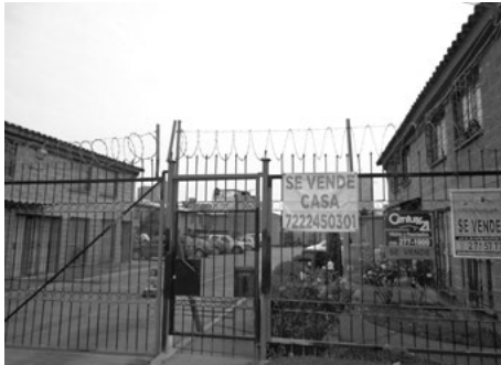
Fotografía 42. Ventas en privada, en el conjunto Geovillas San Mateo II-Independencia , municipio de Toluca
