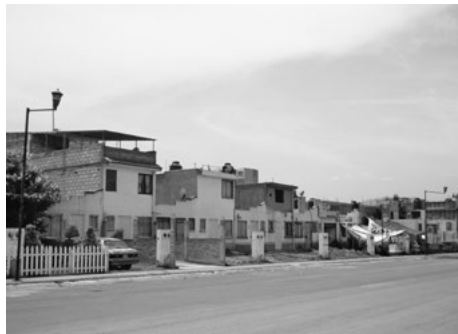
Fotografía 19. Modificaciones a viviendas en el conjunto urbano Colinas del Sol (social progresivo), municipio de Almoloya de Juárez
