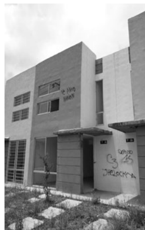
Fotografía 53. Vivienda vandalizada, en el conjunto Valle del Nevado , municipio de Calimaya
