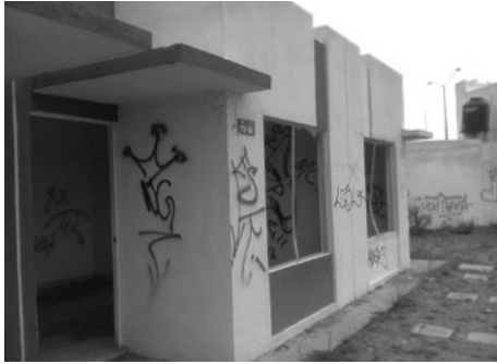
Fotografía 50. Viviendas vandalizadas, en el conjunto Valle del Nevado , municipio de Calimaya
