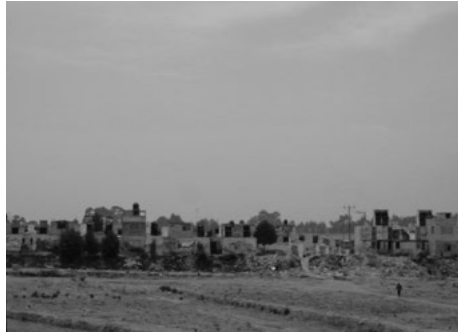
Fotografía 2. Entorno del acceso al conjunto urbano Colinas del Sol , municipio de Almoloya de Juárez
