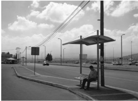
Fotografía 54. Paradero y bahía de espera de transporte público en acceso al conjunto La Loma I
