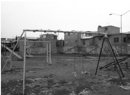
Fotografía 30. Área verde en mal estado, conjunto urbano Geovillas San Mateo II-Independencia , municipio de Toluca
