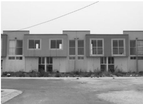
Fotografía 48. Viviendas sin ocupar, en estado de abandono, en calle de retorno en el conjunto urbano Galaxia Lerma , municipio de Lerma
