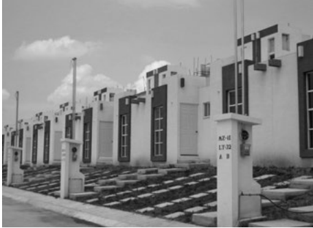
Fotografía 40. Sección de vivienda nueva en etapa de venta, en el conjunto urbano San Diego , municipio de Toluca
