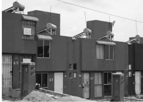
Fotografía 41. Nueva sección en el conjunto Colinas del Sol , municipio de Almoloya de Juárez
