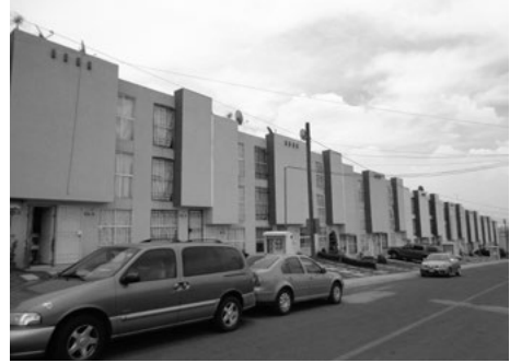
Fotografía 29. Conjunto urbano La Loma II , municipio de Zinacantepec
