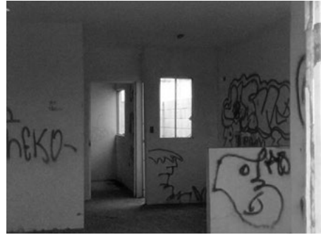
Fotografía 51. Interior de vivienda vandalizada, en el conjunto Valle del Nevado , municipio de Calimaya
