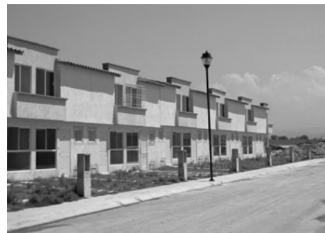
Fotografía 39. Vivienda terminada en proceso de venta, en el conjunto urbano Las trojes II-Hacienda Las Trojes , municipio de Temoaya
