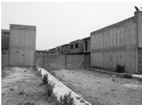
Fotografía 38. Sección de vivienda en construcción, en el conjunto urbano Galaxia Lerma-Paseos de Lerma , municipio de Lerma
