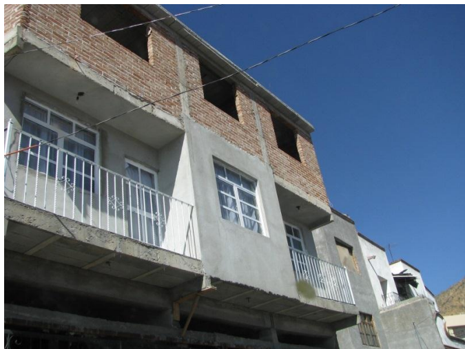
Ilustración 1. Autoproducción progresiva de vivienda. Crecimiento sobre etapas inconclusas.
