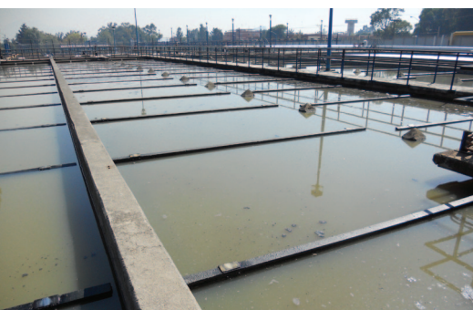
PTAR Cerro de la Estrella, Iztapalapa, D.F.
