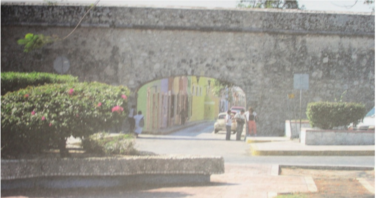
El recinto amurallado, en Campeche, cuenta en su totalidad con todos los servicios urbanos. Destaca la calidad y dotación del alumbrado público aunque se requiere un proyecto integral.
