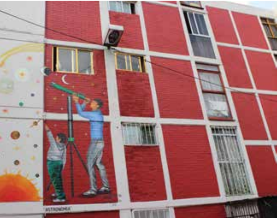
Proceso de embellecimiento de las fachadas exteriores de la Unidad Habitacional La Fortaleza.
