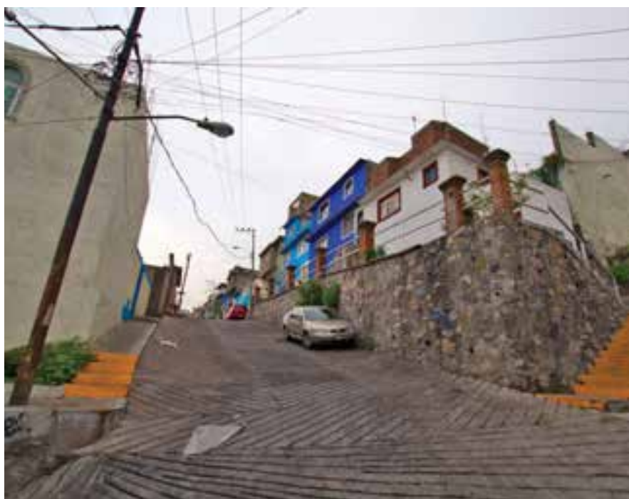
Regeneración de rampa de acceso vehicular.
